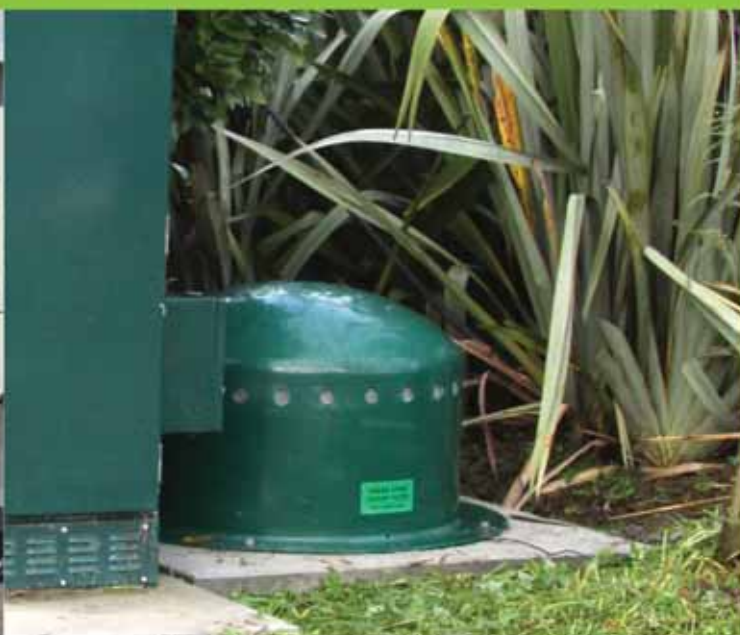
Green Dome Odour Filter - No Fan
